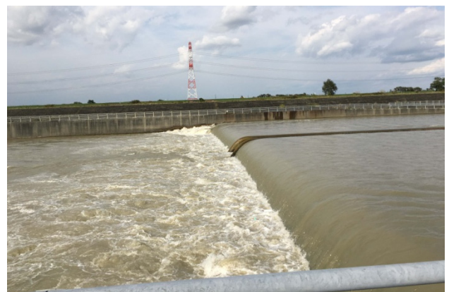
図-2 現在の清幌床止(2016年9月)
